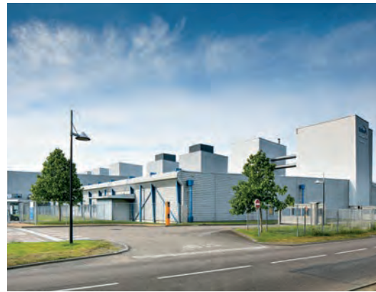
L'usine de fabrication des films pour emballages de Pen-Carn, en Bretagne.
