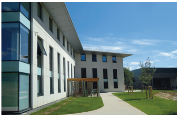
Bâtiment tertiaire certifié HQE « Excellent » et labellisé BiodiverCity® à Nantes. Tertiary building in Nantes HQE-certified "Excellent" and BiodiverCity®.
