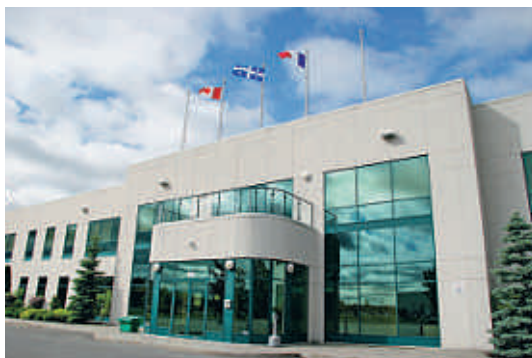
USINE DE BATTERIES (CANADA)
