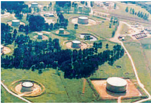
DÉPÔTS SFDM – SAINT-BAUSSANT
